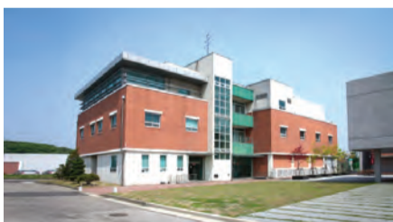
YS생명과학 화성 원료합성공장 전경.
